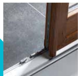
**SEUIL À RUPTURE DE PONT THERMIQUE**
